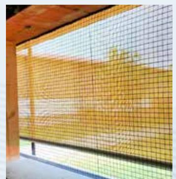
*Der Warmstall mit Außenklimareiz ist ein konventionell aufgebauter Stall, welcher mit einer offenen Fassade versehen wird. Dies ist oftmals die Umbaulösung für Tierhalter, die aus ökonomischen oder baurechtlichen Gründen die Grundfläche des Stalles nicht um einen Auslauf vergrößern können.*
