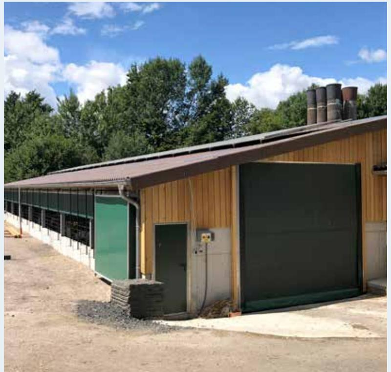
Ein Warmstall mit Auslauf wird im Kern konventionell aufgebaut. Jedoch erhalten die Tiere die Möglichkeit, durch selbstschließende Außentüren in einen zumeist überdachten Auslauf zu gelangen.
